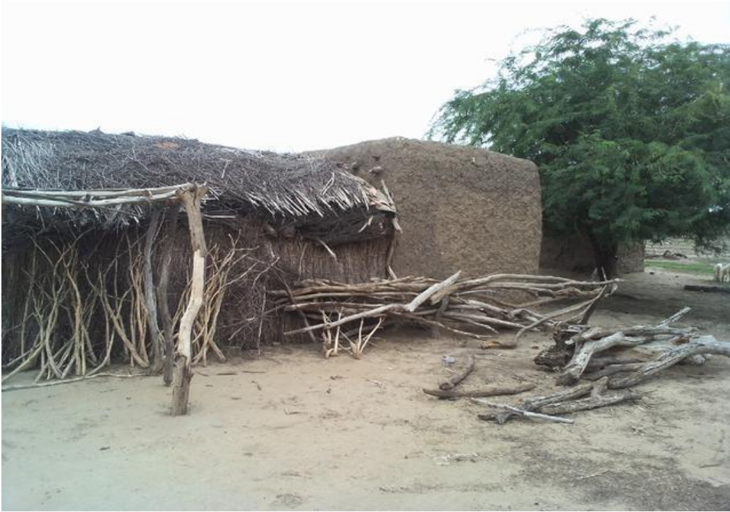
Photo 1: Goulfey-ak massira- ALHADJI DJIDDA Dabouga -36m 2 1Bâtiment de 4pièces mur en terre non crépis toit en paille + hangar
