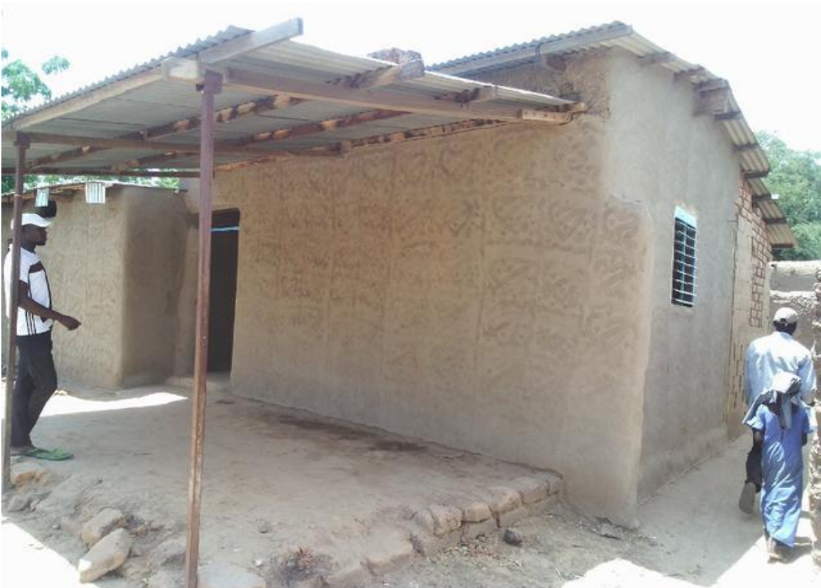
Photo 2: Goulfey Moulouang MAHAMAT Mahamat 1batiment en parpaings crépis simple 5pièces dans le bâtiment sol en dalle simple WC plus hangar (72) m 2
