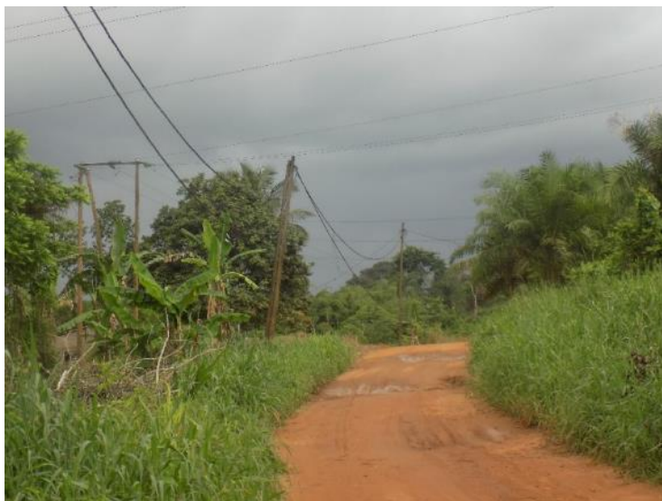
Photo 8 : vue des lignes électriques dans l'Arrondissement de Dizangué
