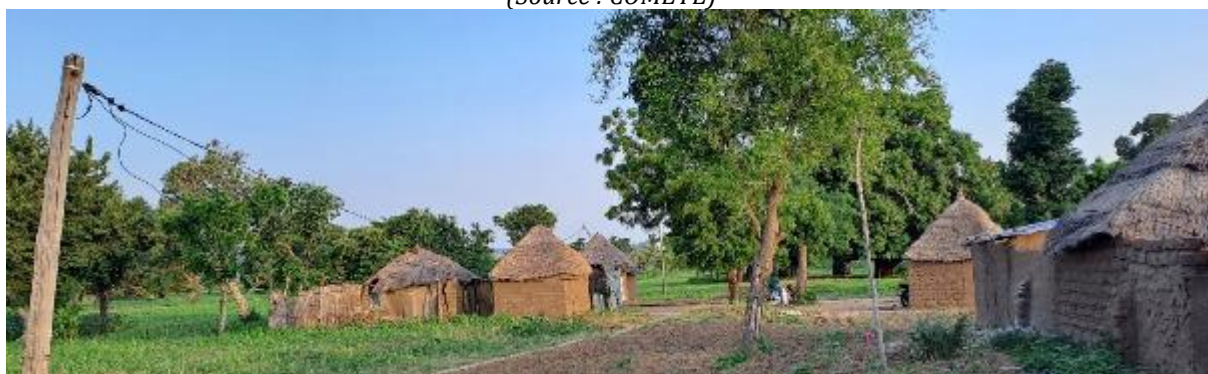
Figure 25: Vue de construction à Tchiffel en zone de risque majeur (Source : COMETE)
