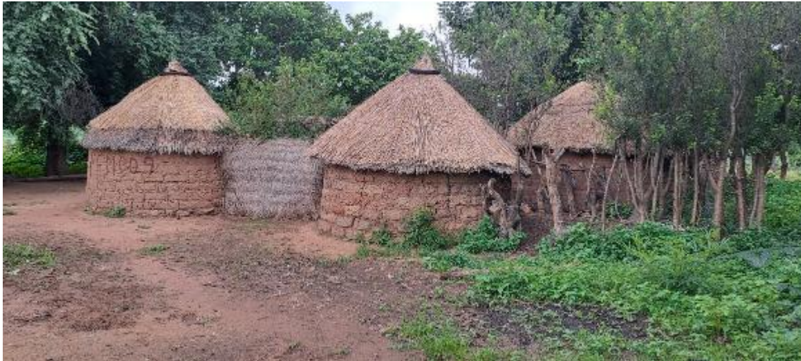
Figure 7: Vue de construction à Houle Source : COMETE
