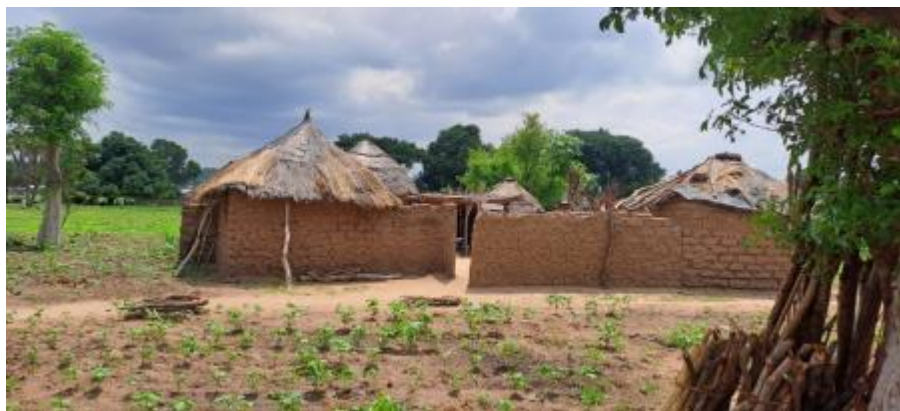
Figure 7: Vue de construction à Barkehi en zone de risque majeur à Barkehi
