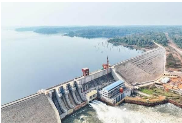
Vue du barrage de Lom Pangar
